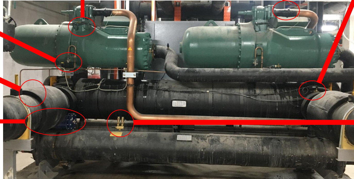
Cảm biến nhiệt độ đường nén
