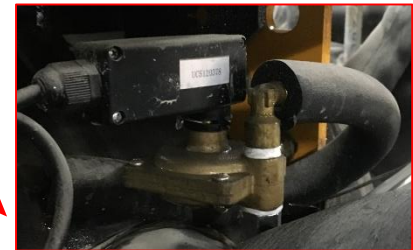
Công tắc chênh lệch áp suất nước
